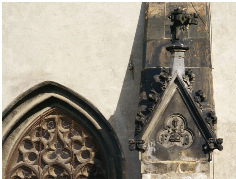
Obrázek 011, 012: Z dronu pořízené záběry poškozené novogotické kytky na opěrném pilíři jižní fasády kostela sv. Mořice v Olomouci.
