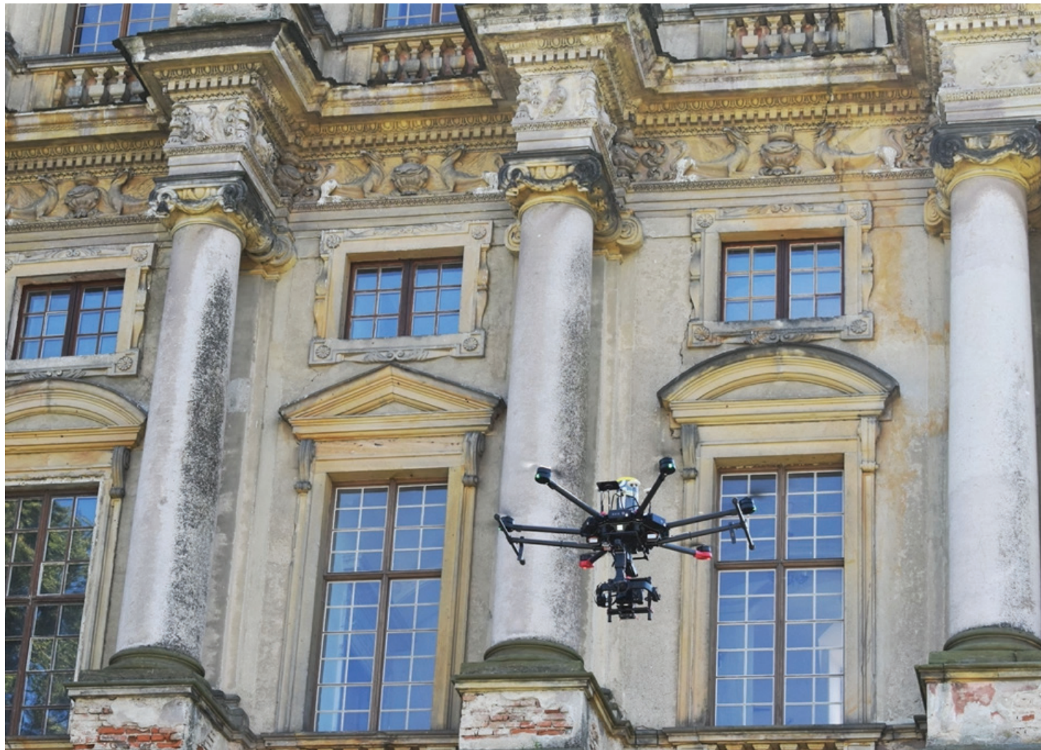
Obrázek 004: Dokumentace severní fasády zámku Plumlov.
