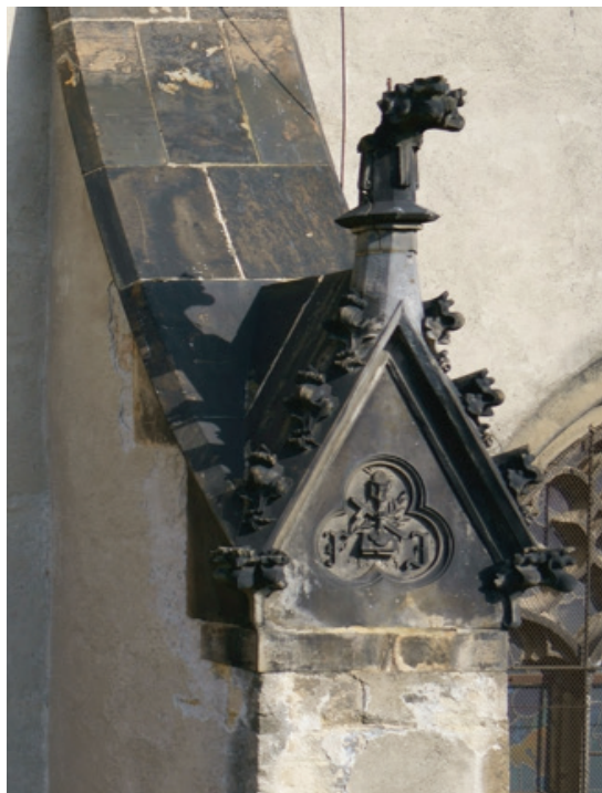
Obrázek 011, 012: Z dronu pořízené záběry poškozené novogotické kytky na opěrném pilíři jižní fasády kostela sv. Mořice v Olomouci.
